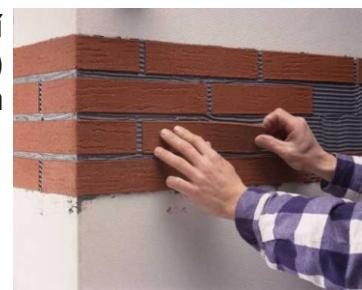
5) Ještě před zavadnutím lepidla musí pomocník obkladače začistit spáry pomocí štětce. Je třeba dbát opatrnosti, aby se přebytečný tmel nedostal na obklad!
