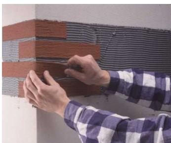
4) Pokračujeme v lepení průběžných pásků ( 240mm ) při dodržení spáry 10-13mm mezi řadami.
