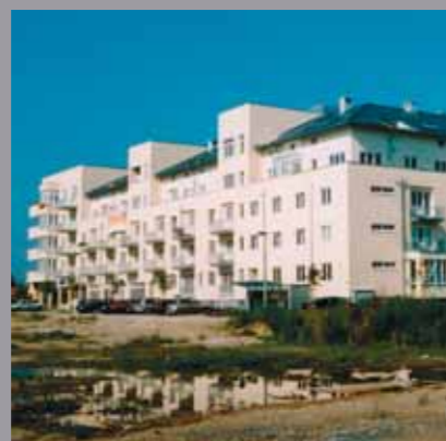
komplex bytových domů Praha Zbraslav osazen střešními okny Kubeso Termo MAX
