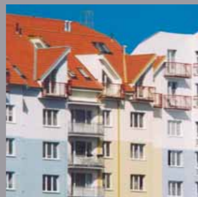
nástavba panelového domu Brno Líšeň
